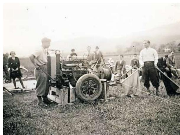
Ein umgebauter Automotor diente als erste Trommelwinde für den Flugzeugstart.
